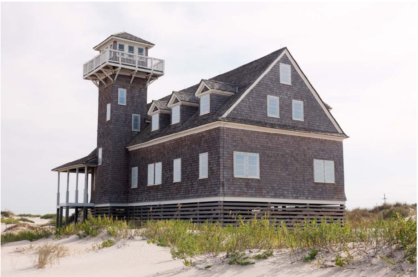
Aspect gris du revêtement dû aux embruns marins.
